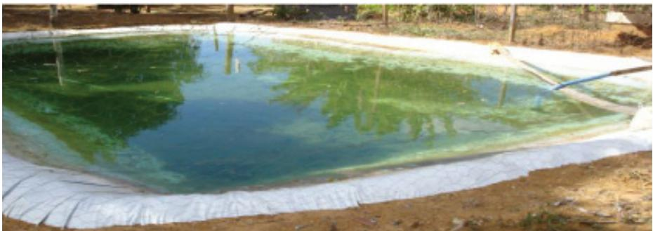
**Figura 10. Reservatório escavado no solo revestido com lona de polietileno branca.**
