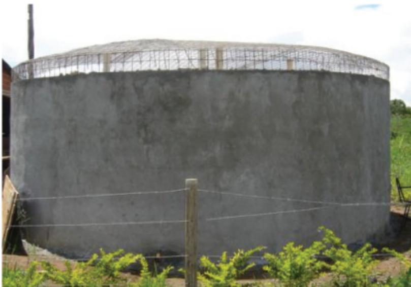
Figura 6. Reservatório de ferro-cimento em construção.
