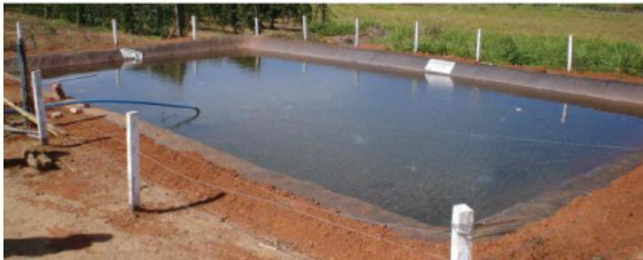
**Figura 11. Reservatório impermeabilizado com lona de PVC.**
