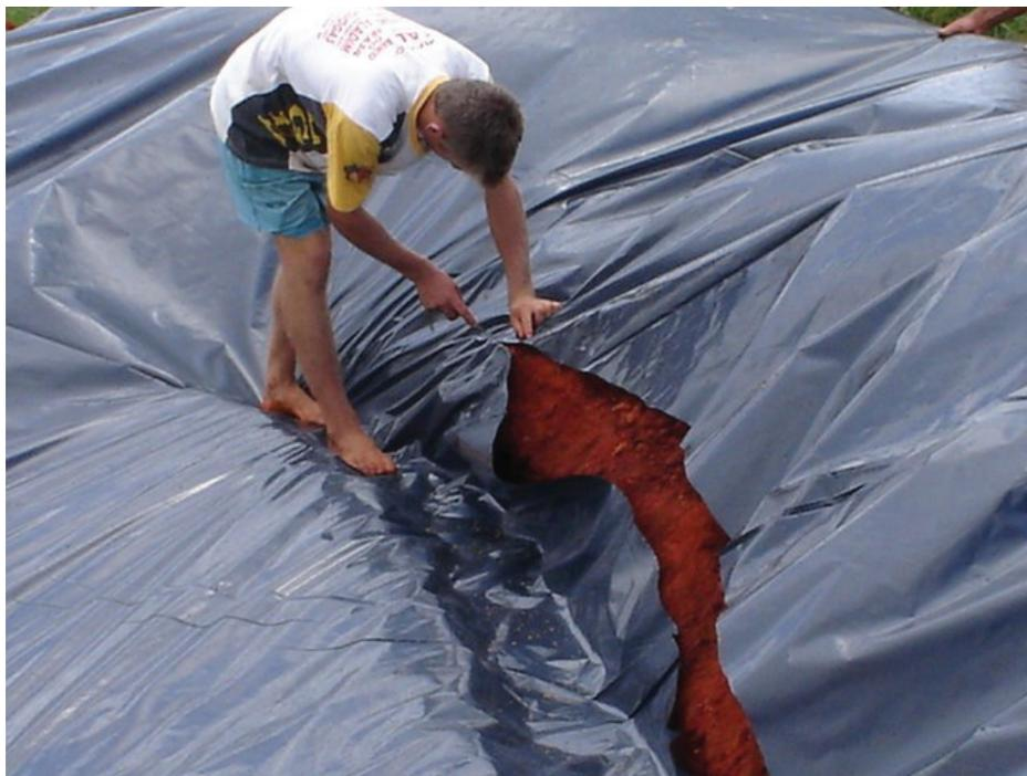
**Figura 25.** Corte das laterais da lona para o encaixe na valeta.
