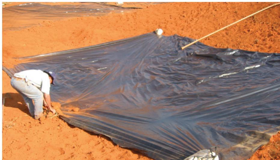
Figura 33. Colocação de lona no centro do reservatório, antes da entrada da água.
