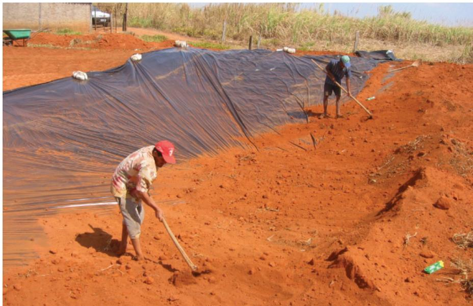
**Figura 29. Nivelamento da terra sobre a lona.**
