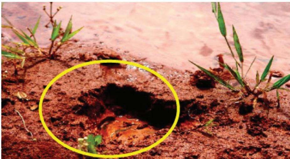
Figura 13. Detalhe da camada de terra cobrindo a lona de polietileno.
