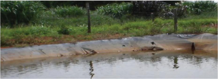
**Figura 9. Reservatório impermeabilizado com lona de polietileno preta.**
