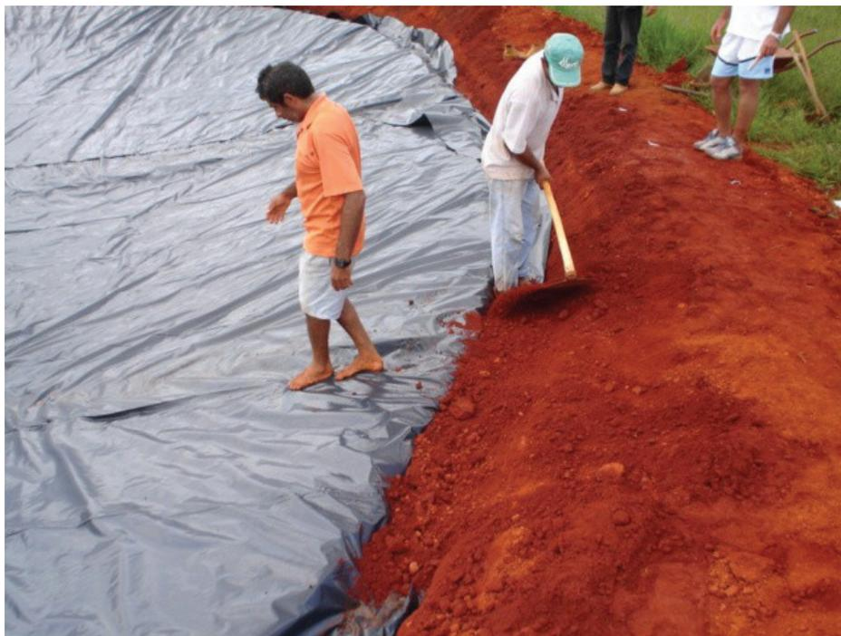
Figura 26. Aterramento da valeta para fixação da lona.
