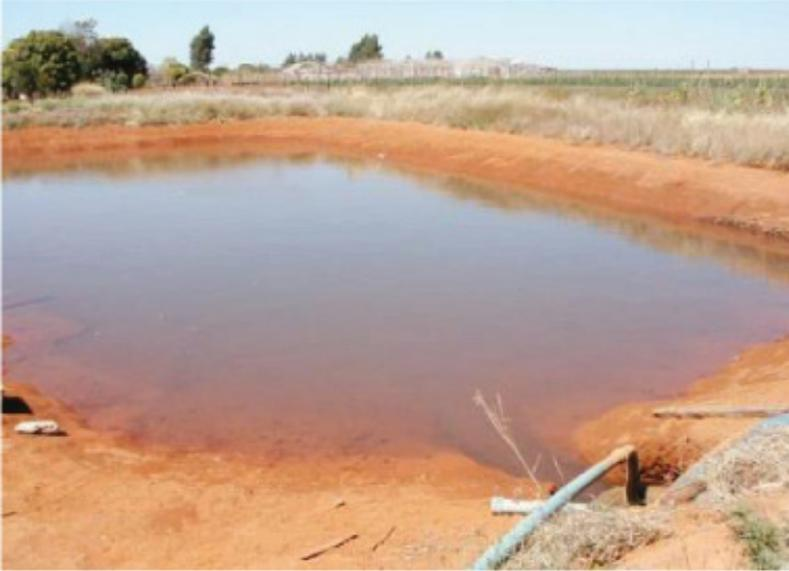
**Figura 7. Exemplo de um reservatório escavado no solo sem impermeabilização.**
