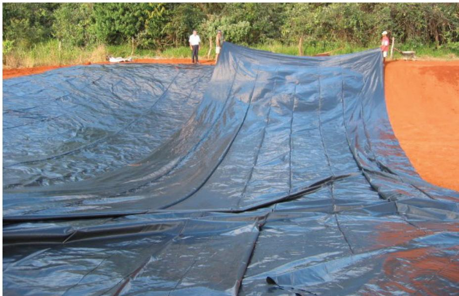
Figura 23. Colocação da lona de revestimento.
