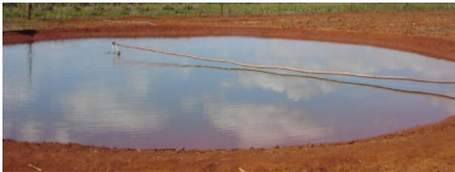
**Figura 12. Reservatório revestido com lona de polietileno coberta com uma camada de terra.**
