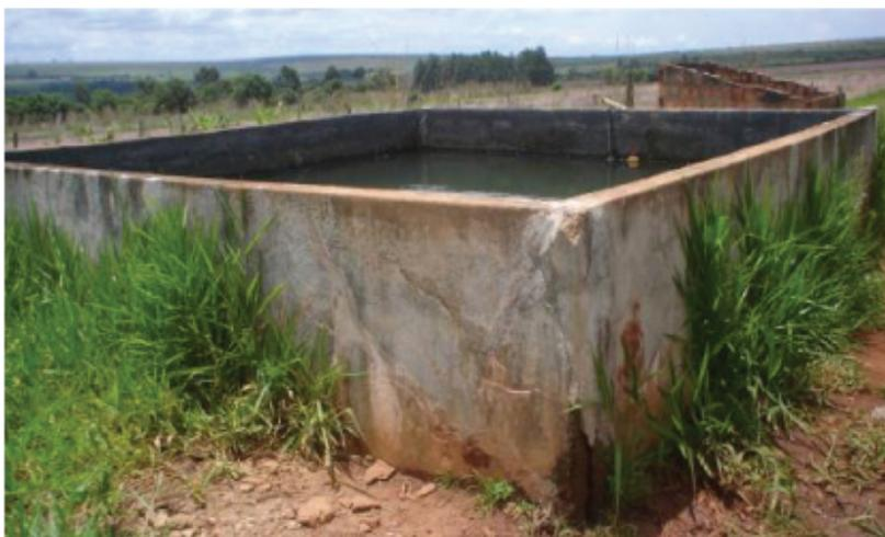
Figura 5. Reservatório construído em alvenaria.
