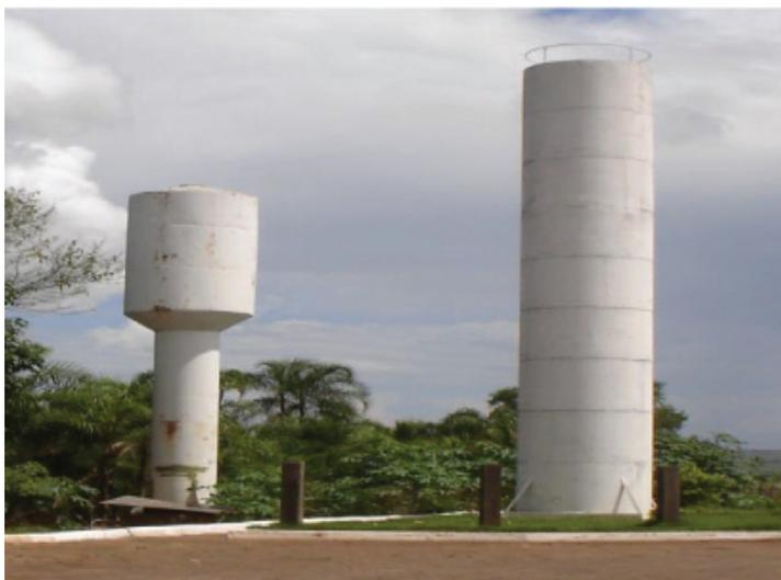
Figura 3. Reservatórios de metal tipo taça e cilindro.
