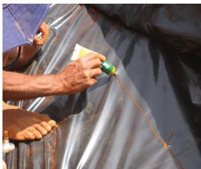
Figura 24. Uso da cola de junta de motor utilizada na emenda da lona.
