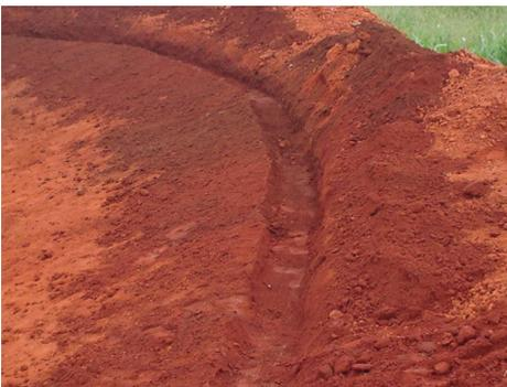
Figura 21. Valeta na borda do reservatório para fixação da lona.
