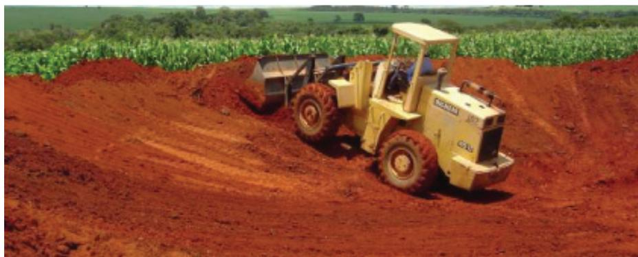
**Figura 17.** Movimentação do solo em direção a borda do reservatório.
