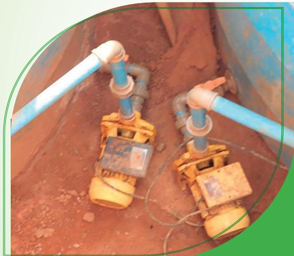
Figura 04. Motobombas afogadas para bancadas coletivas. Fonte: Emater-DF
