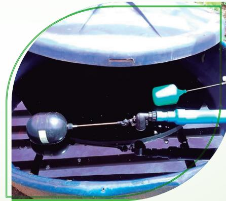
Figura 03. Controle de entrada de água.
