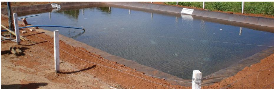
**Figura 26. Reservatório de água para irrigação impermeabilizado com manta de PVC.**
