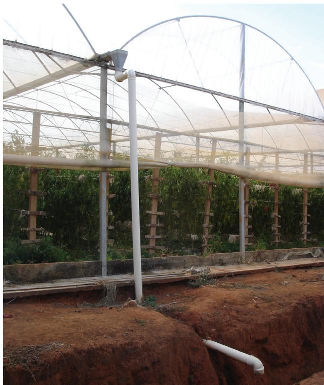
**Figura 5. Exemplo de sistema de coleta de águas da chuva em estufas.**
