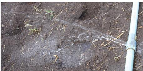
**Figura 36.** Vazamento de água em tubulação de PVC.
