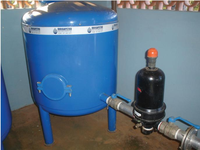
**Figura 33.** Filtro de areia, posicionado antes do filtro de discos.
