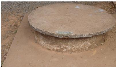
**Figura 22.** Proteção de poço tubular
