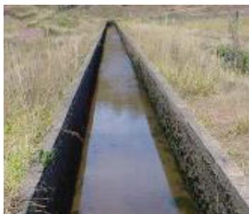
**Figura 24.** Canal impermeabilizado com alvenaria.
