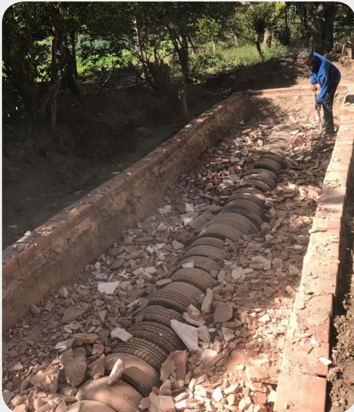
Figura 4. Adição de entulho. Fonte: Emater-DF
