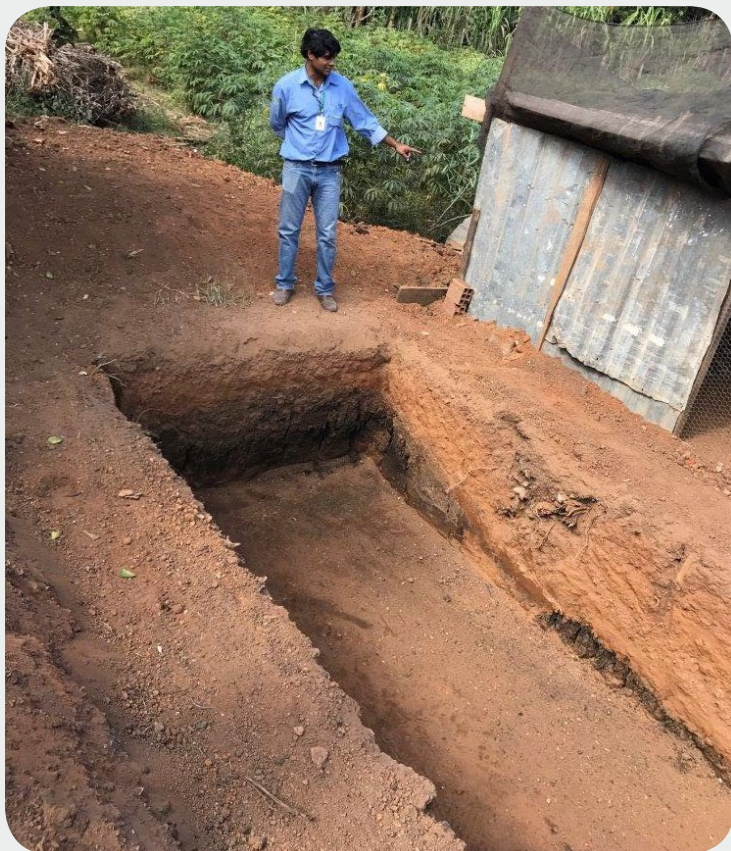
Figura 2. Escavação do tanque. Fonte: Emater-DF
