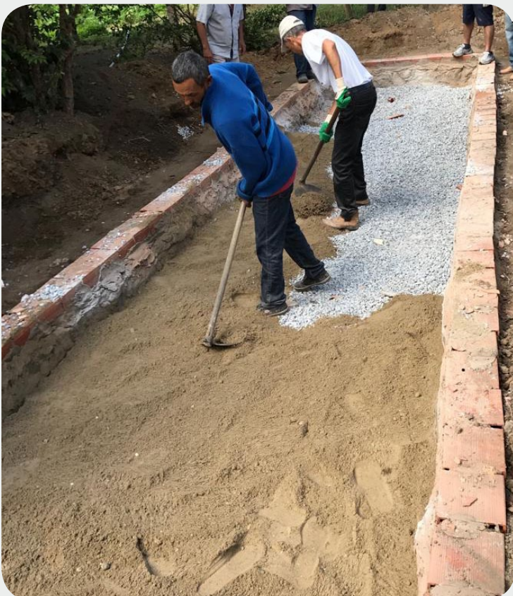
Figura 5. Adição de entulho. Fonte: Emater-DF
