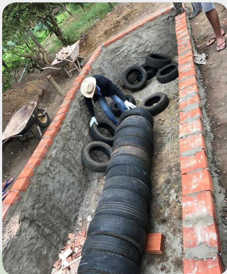
Figura 3. Colocação dos pneus. Fonte: Emater-DF
