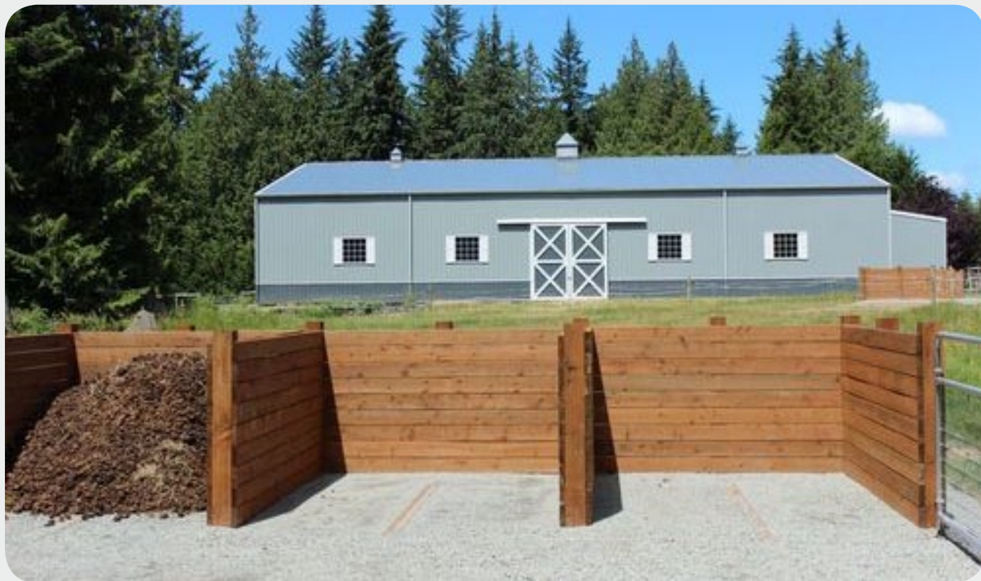
Figura 4. Modelo de esterqueira com piso de alvenaria e paredes de madeira. Estrutura com 3 compartimentos para o tempo de compostagem e formação de novas pilhas.
