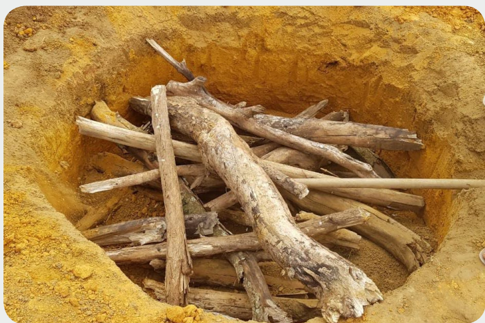
Figura 9. Preenchimento com pequenos troncos e galhos. Fonte: Emater-DF
