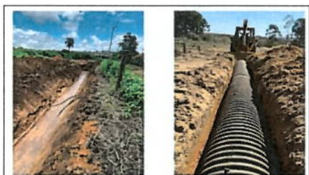
Figura 53. Revestimento de canais de irrigação
