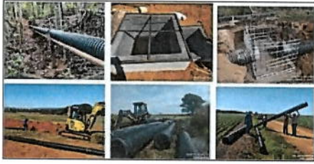
Figura 43. Ações de revitalização de Canais de Irrigação
